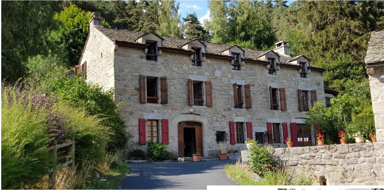
Maison d'accueil de Chaldoreilles à Serverette en Lozère (48700)
